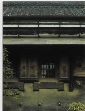
●かつて街道に残っていた蔵。窓の扉に特徴。(昭和56年頃)
